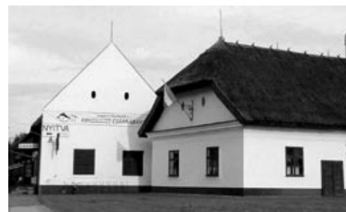
Bal oldalon az új, jobb oldalon a régi Kondorosi Csárda épülete
